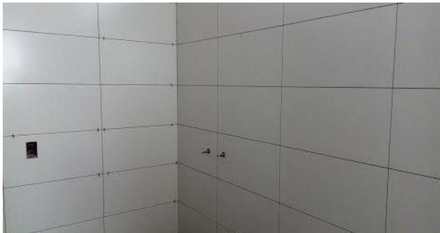
Foto 1: Sentido de colocação da cerâmica nas paredes.
