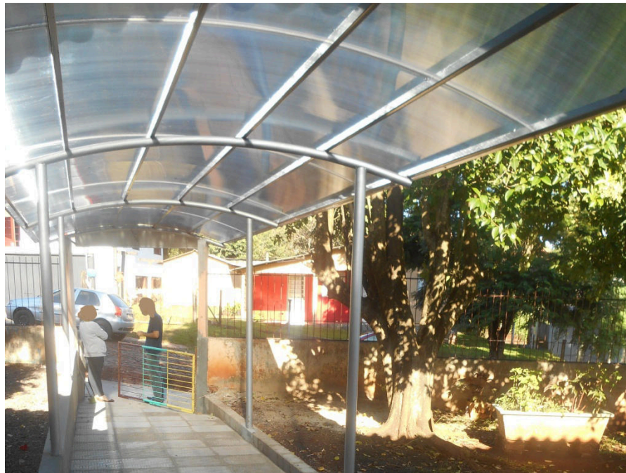
IMAGEM 2 – COBERTURA EM POLICARBONATO
