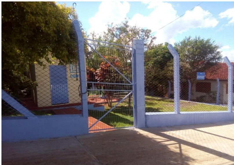
Figura 37 - Poço TPO-03 de captação para abastecimento urbano
