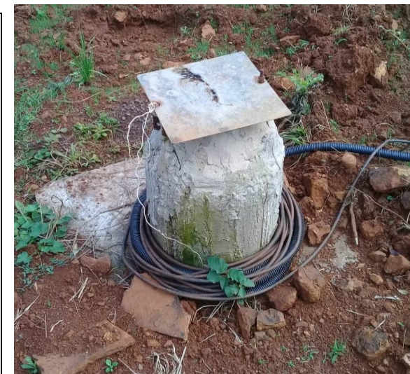
Poço artesiano construído
