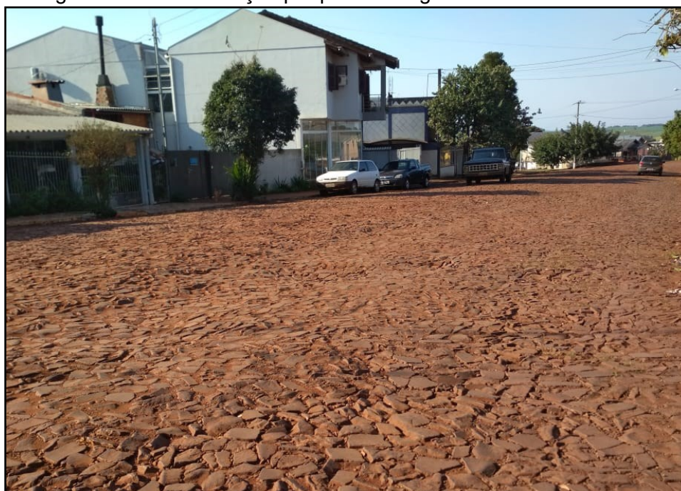
Figura 90 - Pavimentação por pedras irregulares em vias urbanas.
