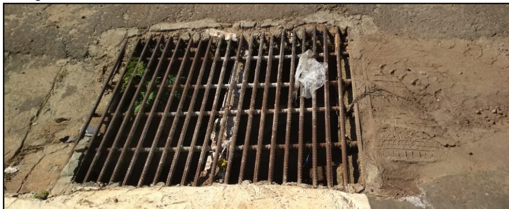
Figura 87 - Boca de loco localizada na área urbana de Tenente Portela.
