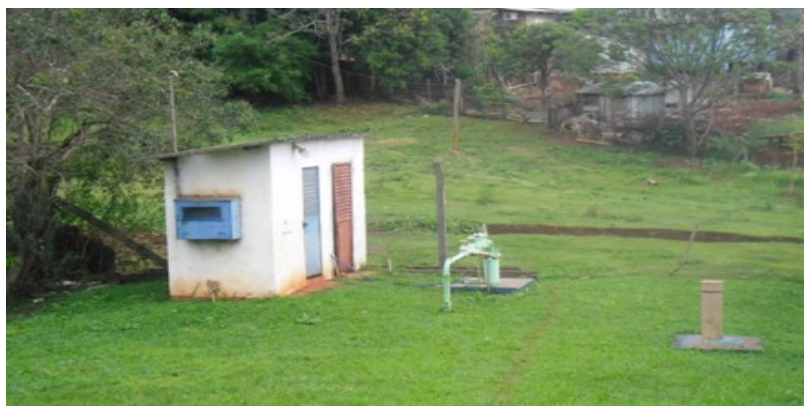
Figura 46 - Poço TPO-31 de captação para abastecimento urbano
