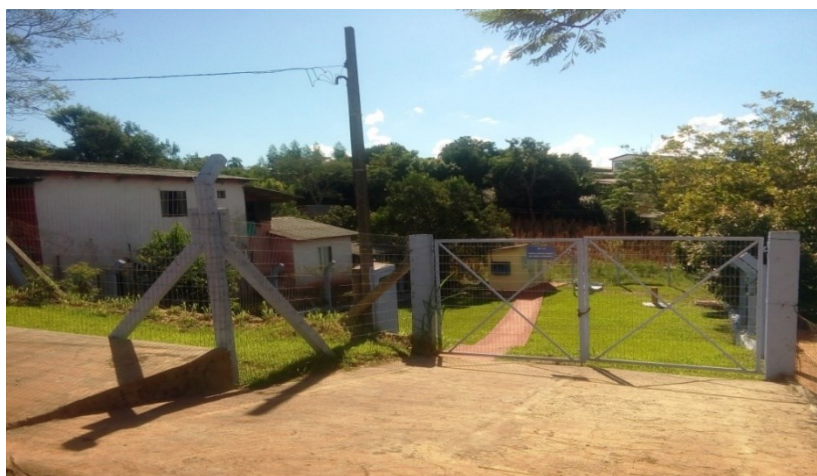
Figura 41 - Poço TPO-10 de captação para abastecimento urbano
