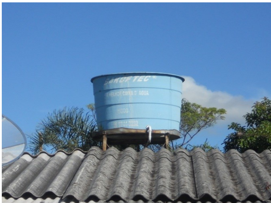
Figura 51 - Reservatório elevado com capacidade de 5 m 3
