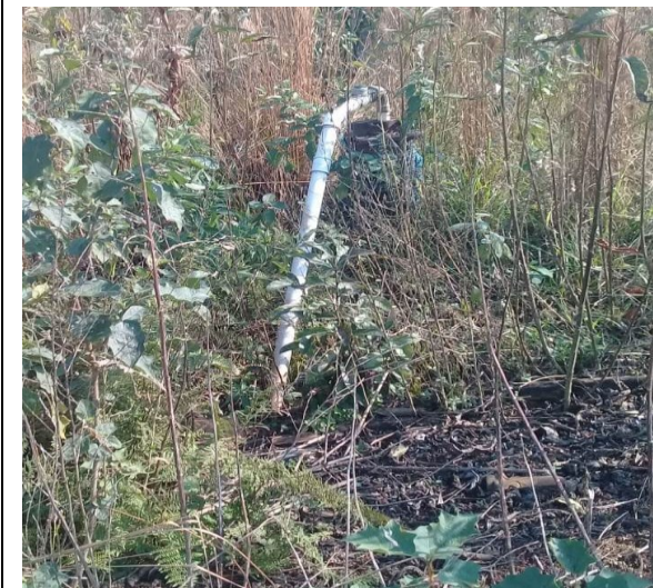
Área em torno do poço
