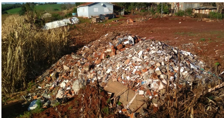
Figura 126 - Disposição inadequada de RCC.
