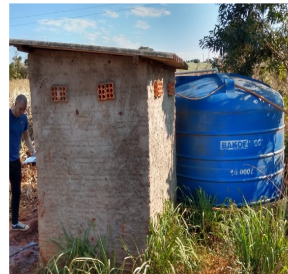
Reservatório e infraestrutura
