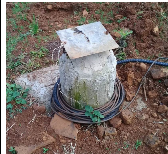
Poço artesiano construído
