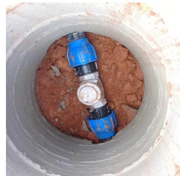
Conexão da rede nova
