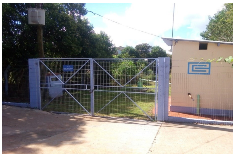
Figura 38 - Poço TPO-06 de captação para abastecimento urbano
