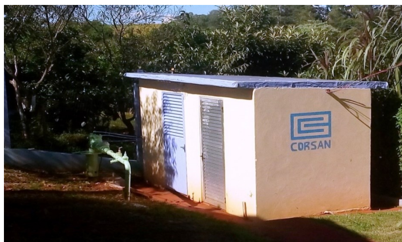
Figura 42 - Poço TPO-11 de captação para abastecimento urbano
