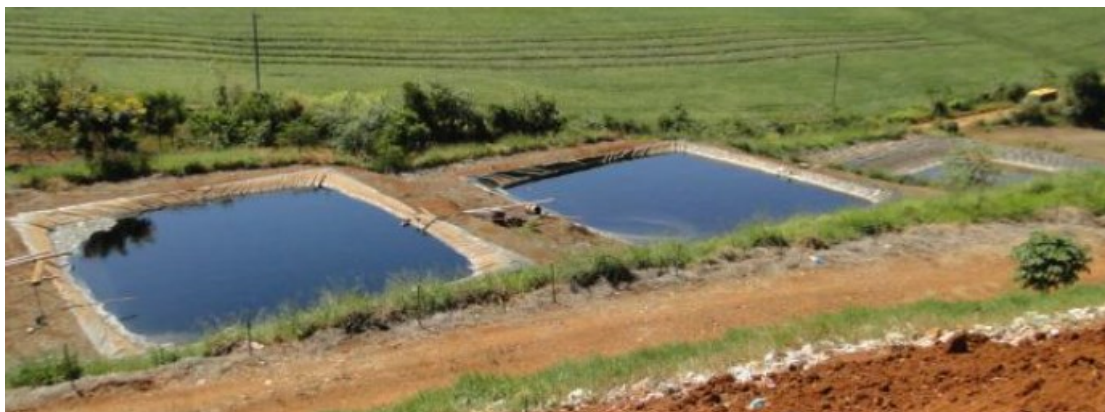
Figura 106 - Sistema de lagoas para tratamento de percolado (chorume).
