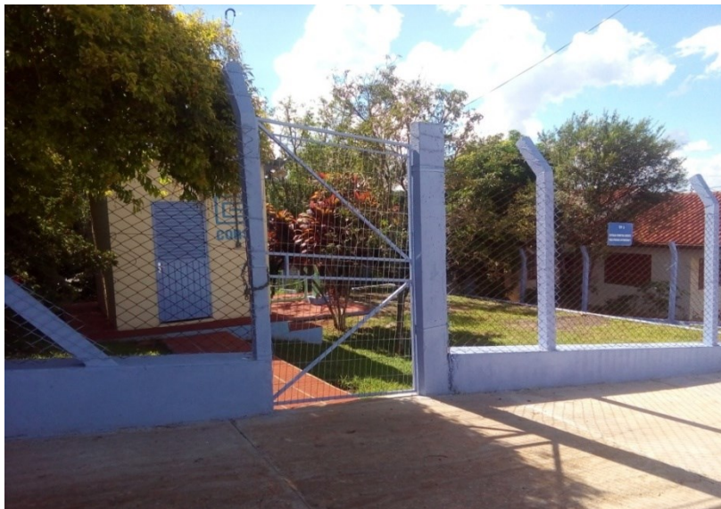
Figura 37 - Poço TPO-03 de captação para abastecimento urbano
