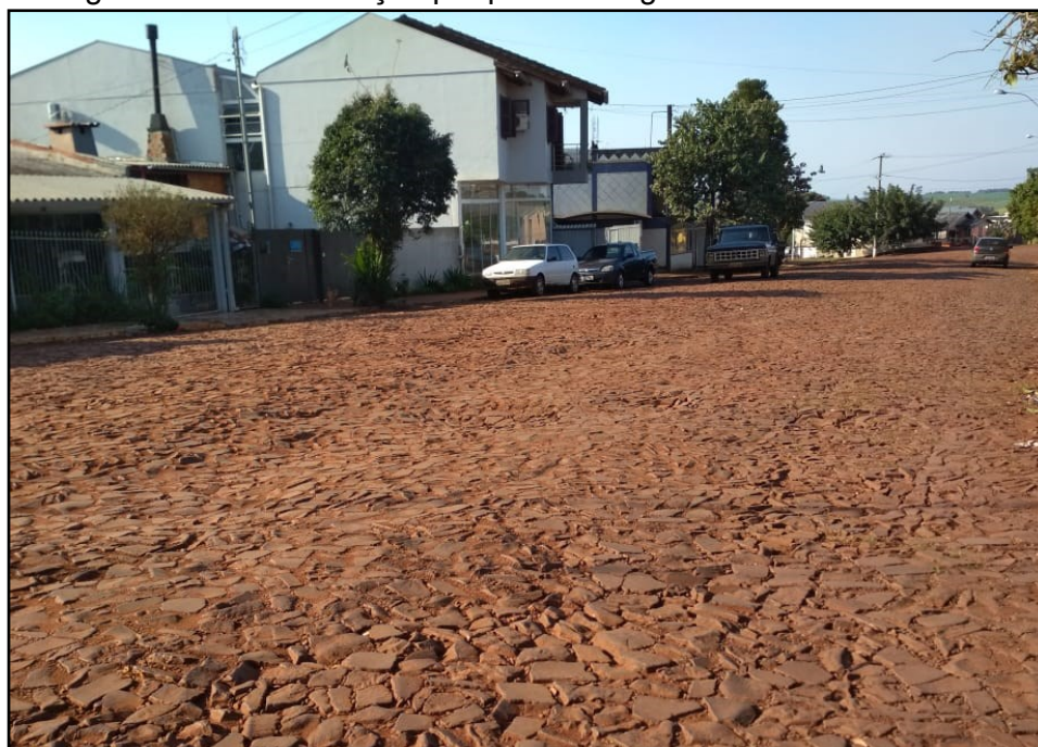
Figura 90 - Pavimentação por pedras irregulares em vias urbanas.
