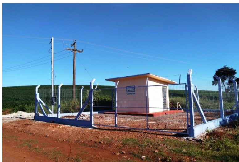
Figura 48 - Poço TPO-45 em construção
