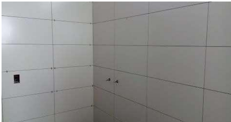
Foto 1: Sentido de colocação da cerâmica nas paredes.
