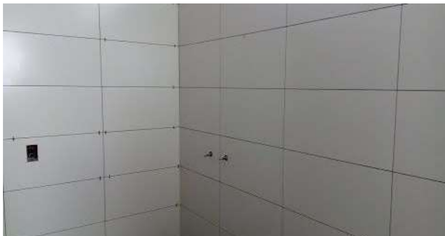
Foto 1: Sentido de colocação da cerâmica nas paredes.
