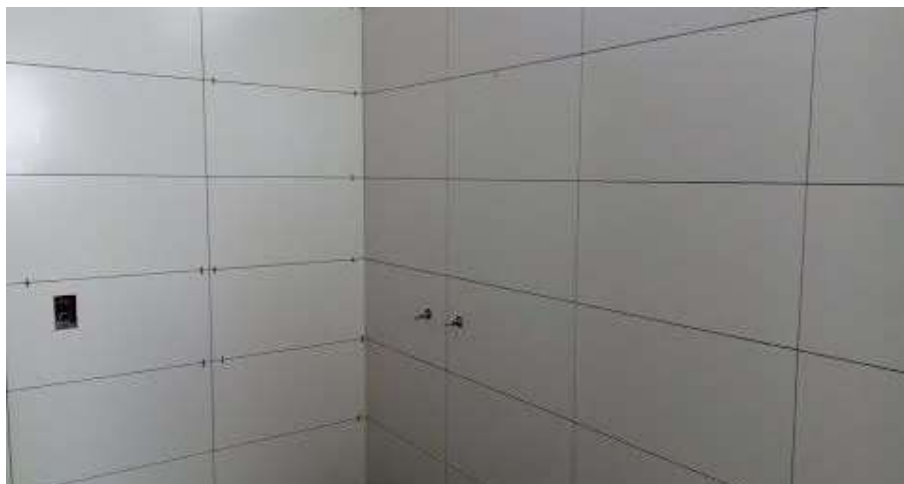
Foto 1: Sentido de colocação da cerâmica nas paredes.
